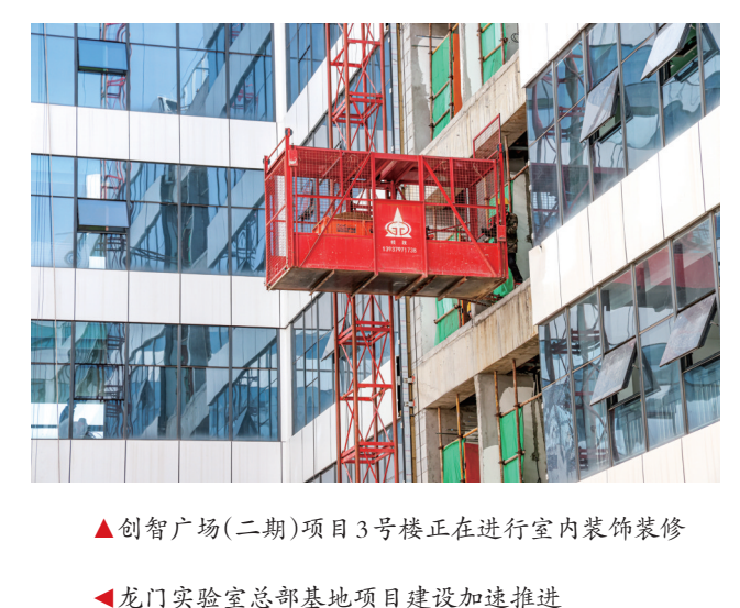
▲创智广场(二期)项目3号楼正在进行室内装饰装修
