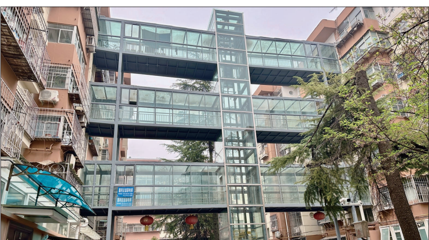
涧西区石化新区家属院加装的连廊式共享电梯
