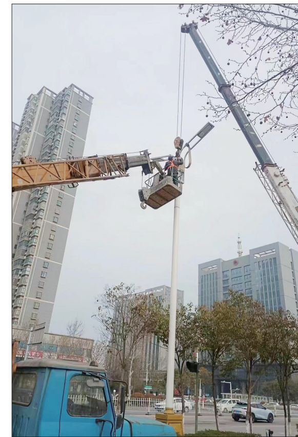
路灯提升改造现场
