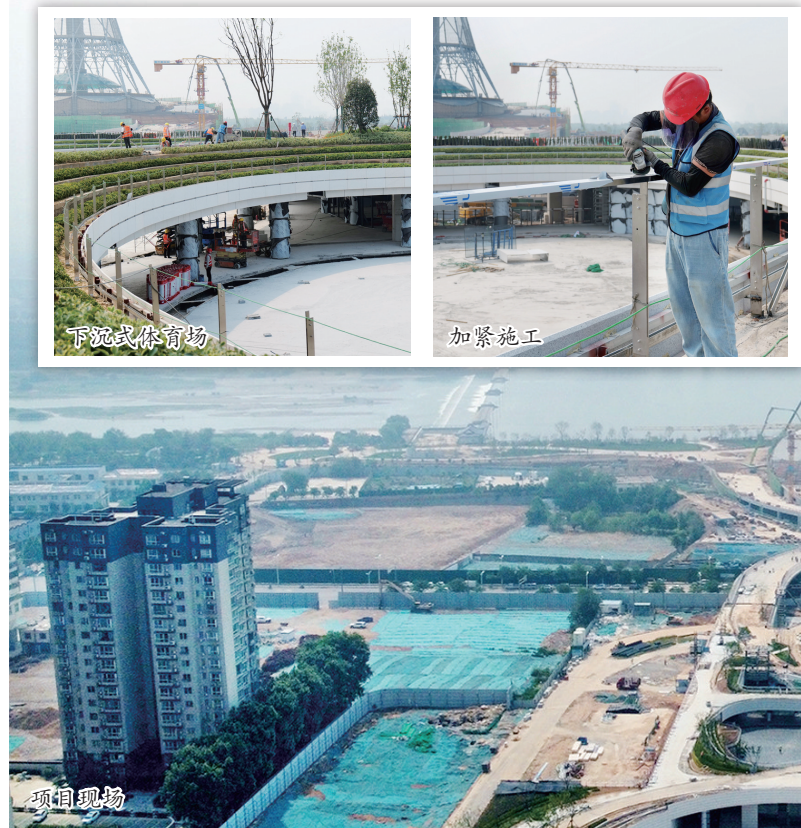
下沉式体育场 加紧施工 项目现场
