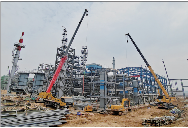
项目建设现场
