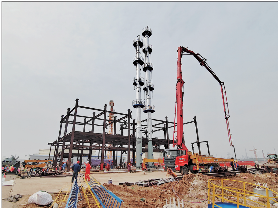
项目建设现场
