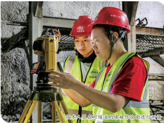
技术人员在对隧道的爆破作业面进行测量
