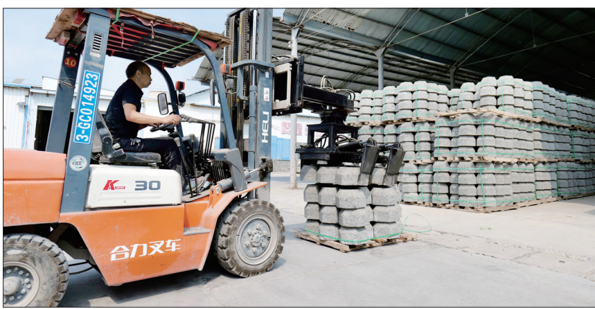
运送蜂窝状混凝土砌块
