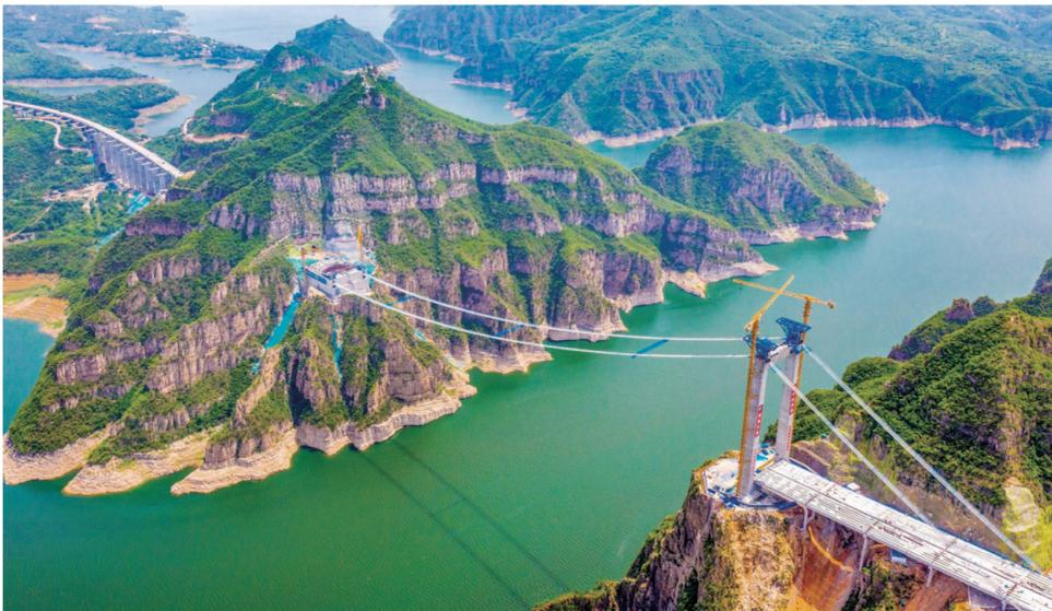
在位于新安县石井镇的济新高速公路黄河大桥项目建设现场，大桥上部结构施工加紧推进，工人正在进行大桥猫道建设，为后续大桥主缆架设做准备。
