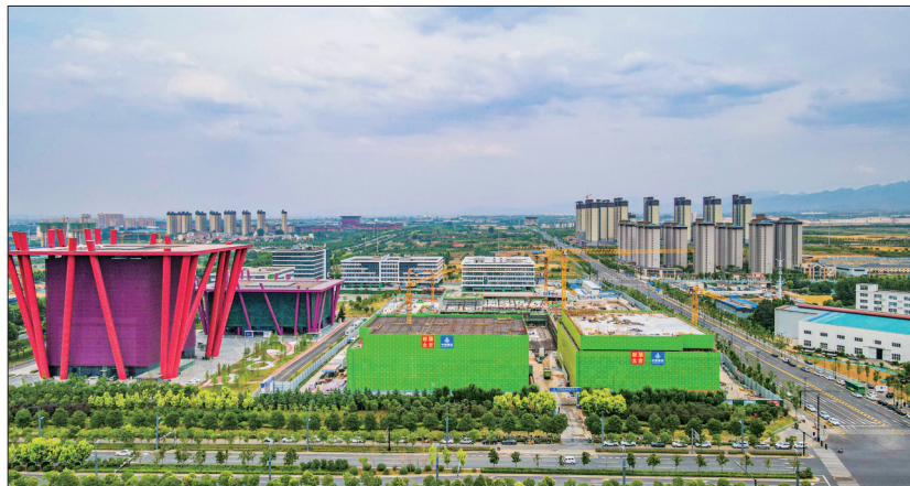
“两中心”顺利实现主体封顶
