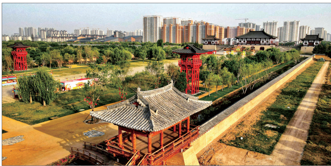
天街两侧坊门、坊墙、望楼等景观初显。(资料图片)
