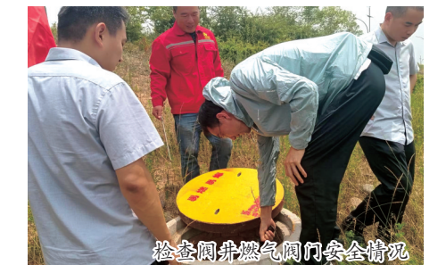
检查阀门燃气管门安全情况
