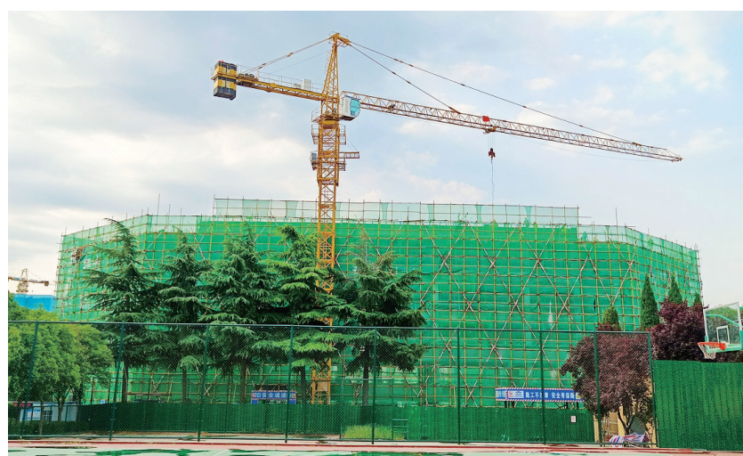
河科大附中高新校区新建教学楼项目主体封顶
