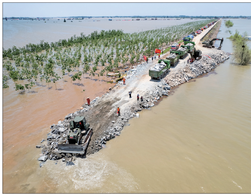
7月7日,在湖南省岳阳市华容县团洲垸洞庭湖大堤决口现场,抢险队伍在进行堵口作业,预计9日12时前完成封堵。(新华社发)
