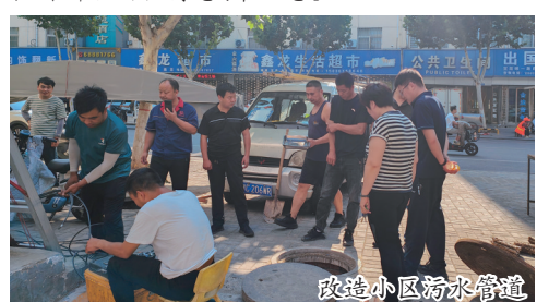
改造小区污水管道
