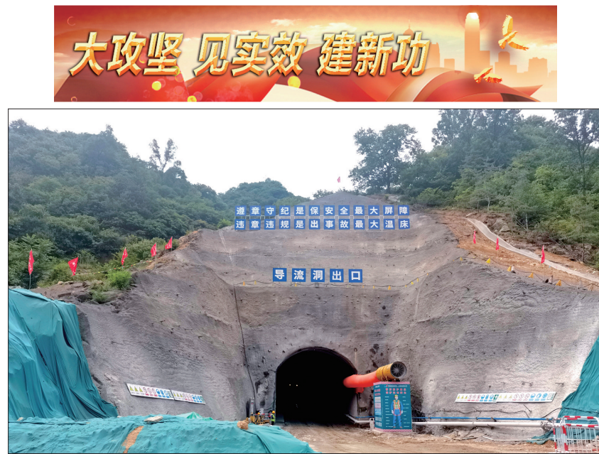
正在建设的抽水蓄能电站导流洞
