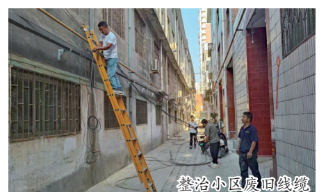
整治小区废旧线缆
