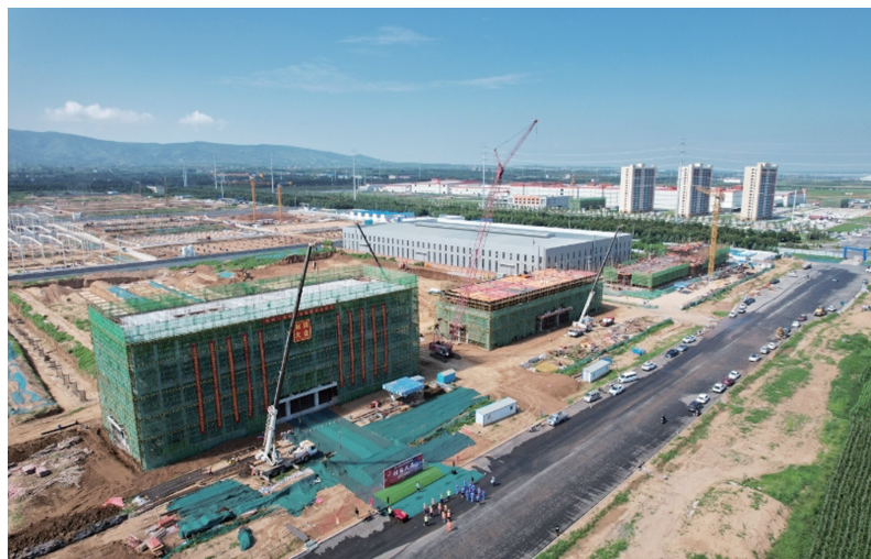
洛阳新能源产业园建设现场
