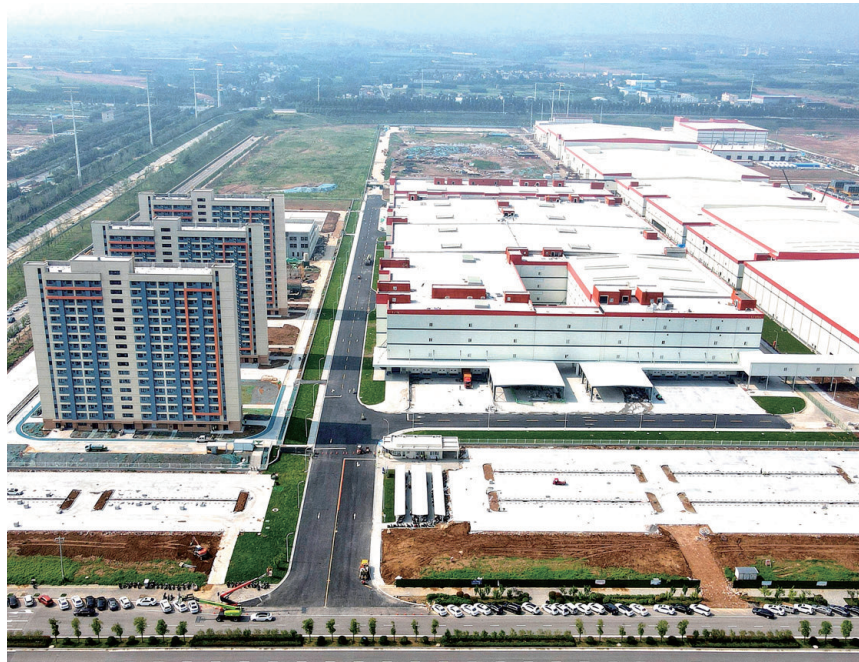
宁德时代洛阳基地项目现场 (资料图片)
