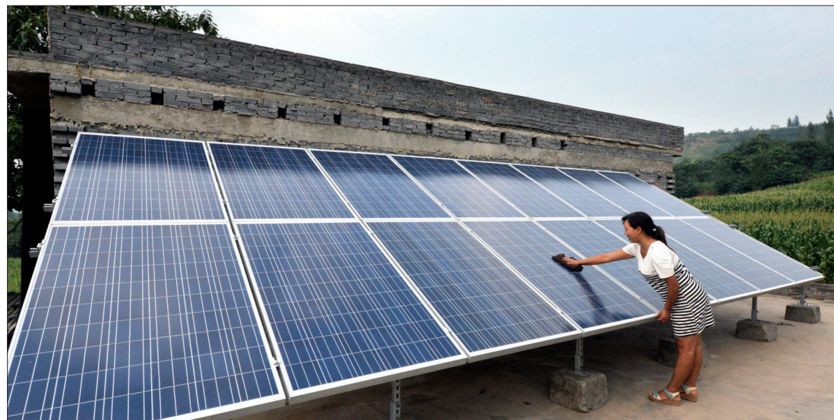
擦洗太阳能电池板
