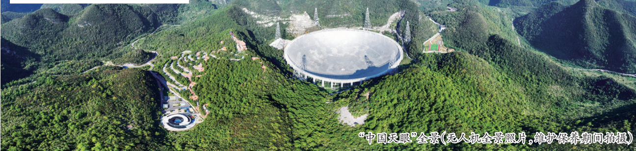
首台核心阵试验样机在吊装中(无人机全景照片)
