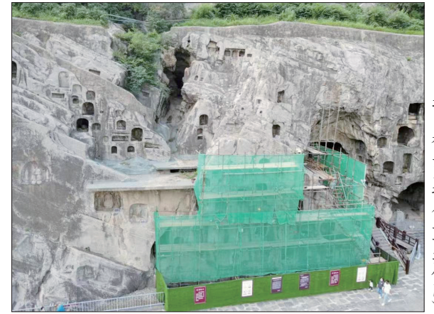
项目施工区域（王青茹供图）
