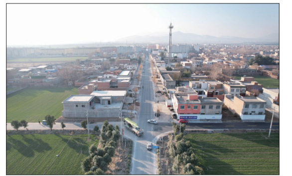
车辆驶入改造提升后的环镇路
